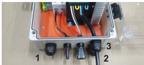
Figura 14: Passagem do cabo pelo prensa cabo nº3.
